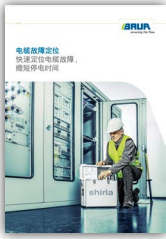
电缆故障定位
