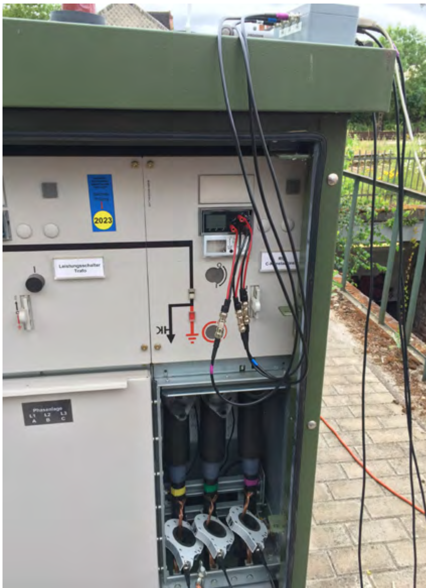
Рис. 3. Для сравнения качества измерений прибор для измерения частичных разрядов Iiopa был подключен к новому соединительному устройству с системой детектирования напряжения для обнаружения ЧР (VDS-PD датчику) (вверху) и к датчикам HFCT (внизу).
