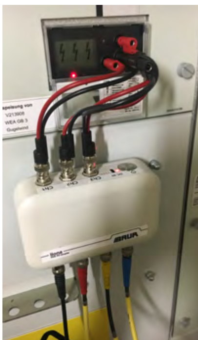
Imagen 1. Conexión del medidor de descargas parciales a los zócalos VDS de la cabina de un parque eólico
