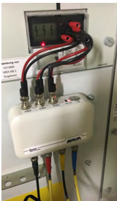
图 1。将局部放电测量仪连接到风电场开关设备的 VDS 插座上
